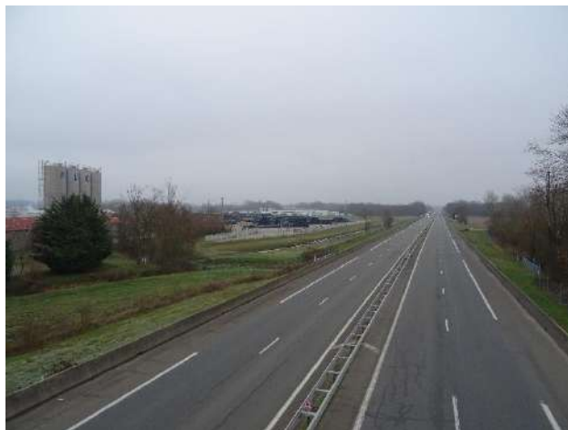
Fragmentation des espaces naturels par l'autoroute A40 et l'urbanisation à Feillens
