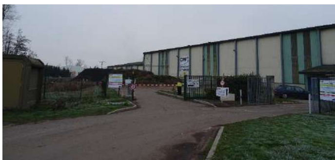
Plateforme de compostage collective à Feillens
