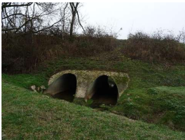
Ouvrage de transparence hydraulique et écologique sous la RD933 à Feillens
