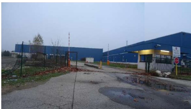
Entrepôts de Kuehne Nagel à Laiz fermés et en transfert d'activité
